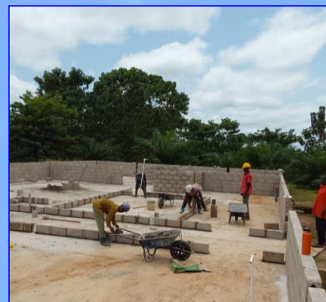
Bouw van het 2e gebouw bij de dependance van Hoop Kliniek
